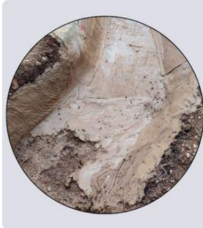
Construcción e impermeabilización de zonas de agua con materiales naturales locales y técnicas culturales.
