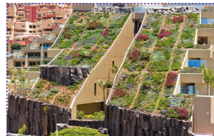
Figura 41. Cubiertas inclinadas del Hotel GF Victoria (Tenerife). Fuente: zincocubiertas-ecologicas.es
